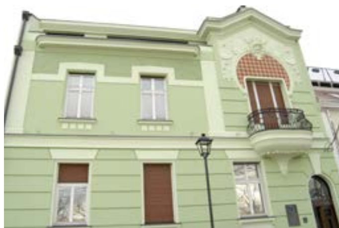
Сл. 6 / Општи изглед куће након завршених радова 2018. године (Снежана Нејовановић)
