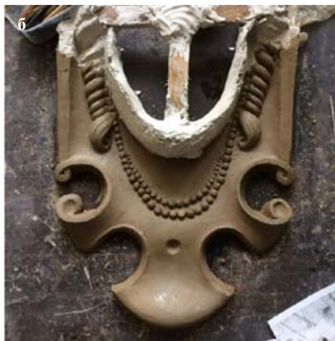
Сл. 5 / Конзерваторско-реституирајорски радови на реституцији фасадне декоративне пластике (а: аутор рада Раде Мрљеш, б: извођач радова Ненад Перућ)
