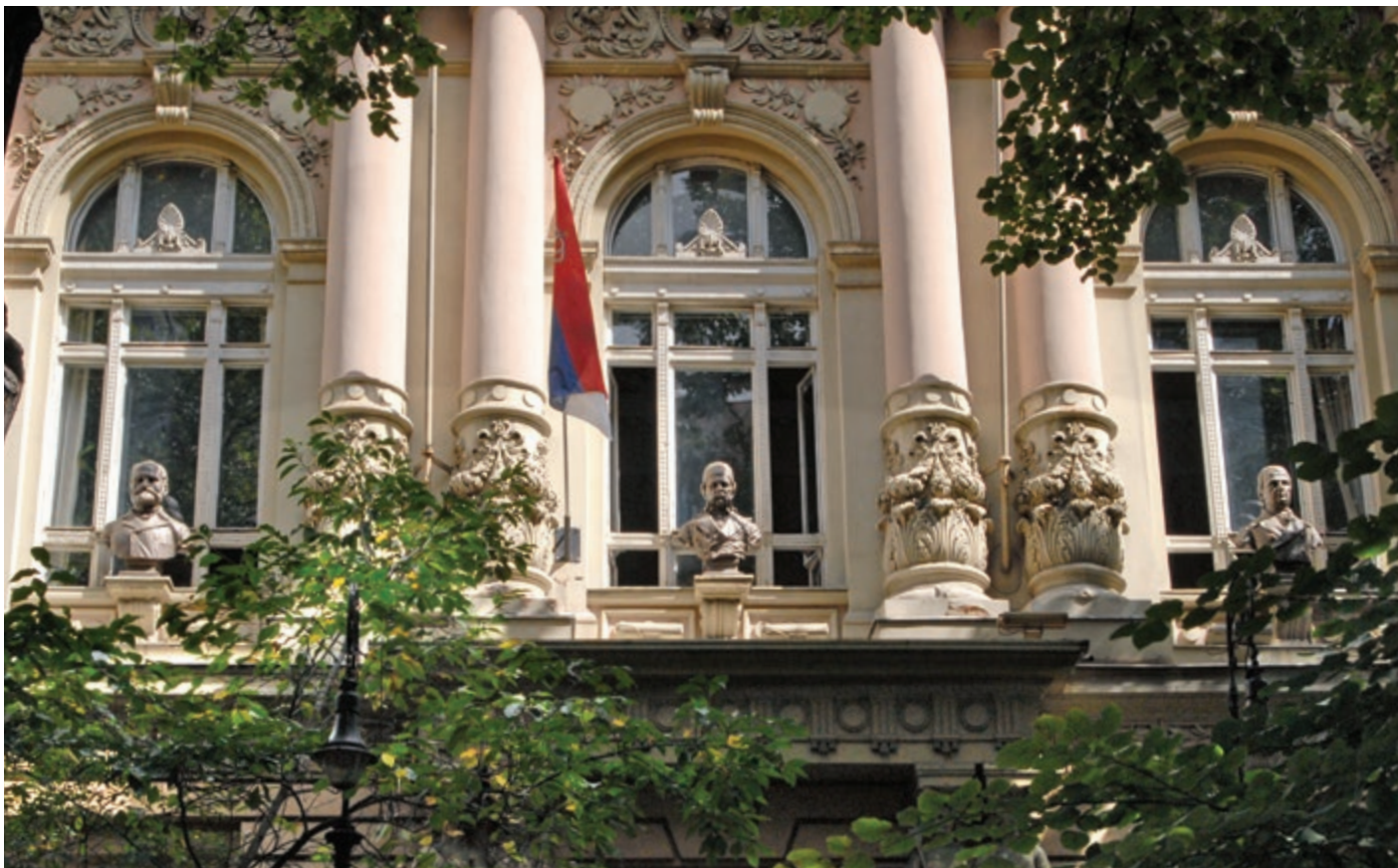
Сл. 4 / Три бисте Пејтра Убавкића, зграда Треће београдске гимназије у Београду. Извор: Завод за заштитну споменика културе града Београда
