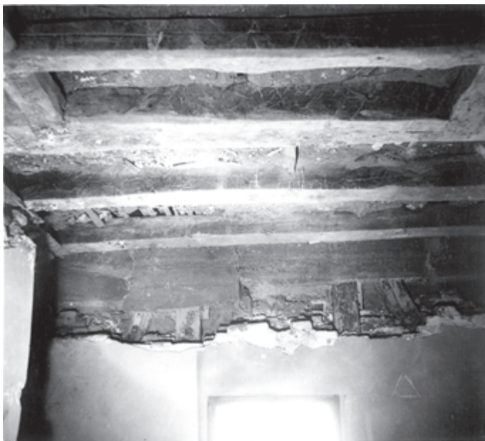
Сл. 4 / Конак кнеиње Љубице, међуслојна дрвена њаваница и фасадни зид снимљени пре извршених реставрационских радова (документација ЗЗСКГБ)
