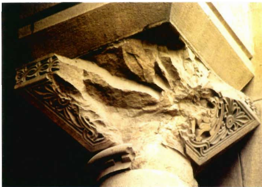
Сл. 3. Механичко оштрење од пројек- тила из Другог светског рата на капителу аркадне нише са бочне стране обалног стуба бр. 4
