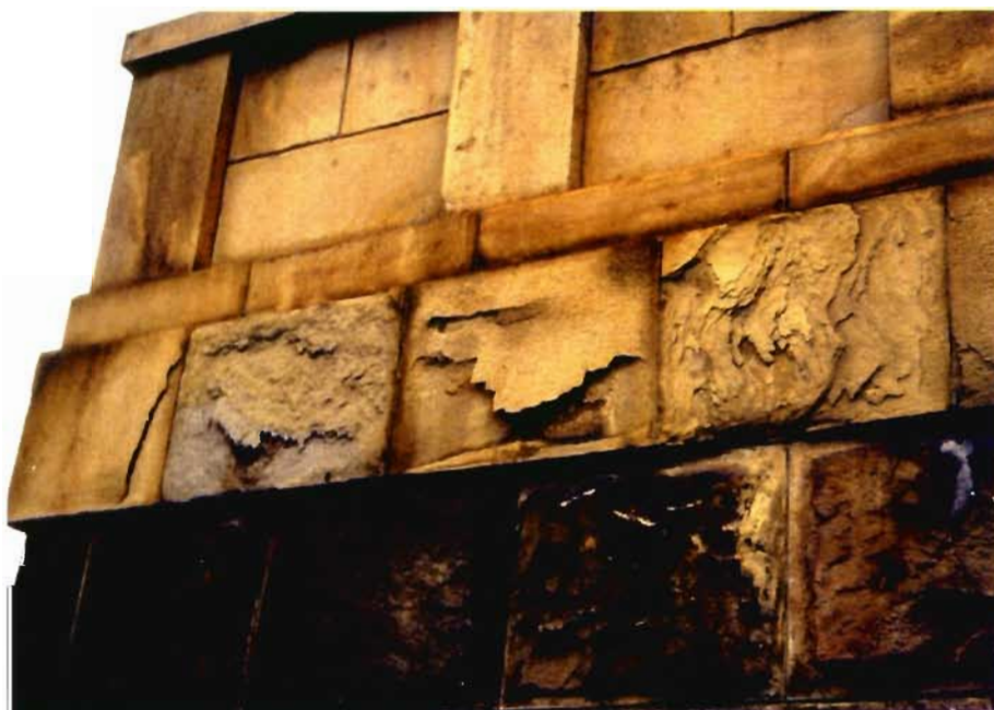
Сл. 6. Различити степен оштећења камених елемената обрађених на зубљеним чекићем; нејромењене површине (а), елементи са одвојеном слојевитом љуском мањевише разграђеном (б), широким патицирани елементи са сачуваном љуспастом обрадом (в)
