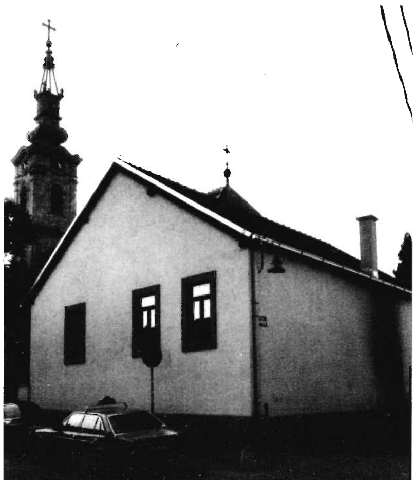
Сл. 4. Изглед новог објекта, август 1998. године
