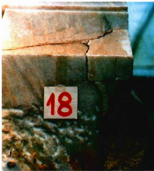
Сл. 7. Консолидовани фрагменти постоља крета – храм св. Ђорђа пре и после реститурације
