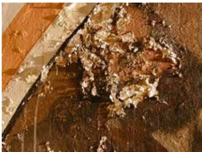
Сл. 1. Снимак накнадног провлаживања из 1995, насталог од новог иродора влаге. Развој водљусианих површина бојеног слоја
