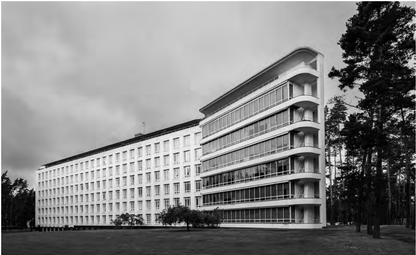
Сл. 4. Санаторијум у Паимију, архитектуре Алвара Алија (јужна страна)
