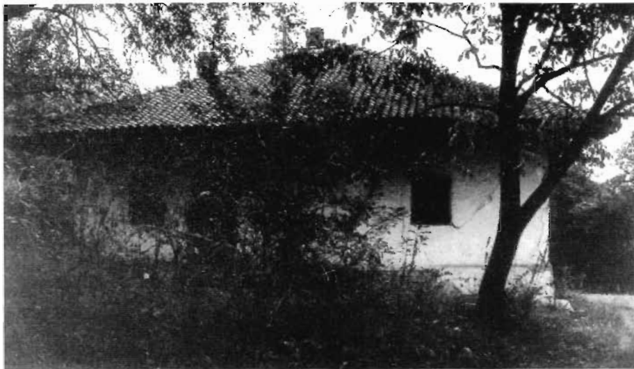
Сл. 11. Кућа породице Стјефановић – предња фасада (фото: Н. Живковић)
