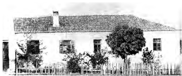
Сл 1. а. Изглед текије Хаџи шеих Мухамеда у Београду: зграда, главни улаз и турбе, цртеж Луке Младеновића, уписана година 1808; б. Технички снимак текије, цртеж архитекте Андрије Вуковића из 1865. године; в. Фотографија текије, снимко Ганшенбајн 1865. године
