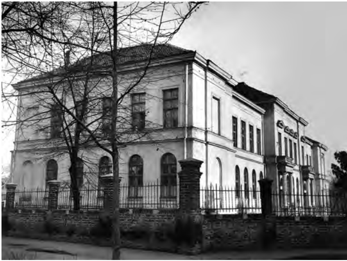
Сл. 1. Главна фасада
