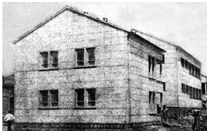
Сл. 6. Фотографија изведене монтажне куће типа „монт МГ 1“, на градилишту (илустрација преузета из: Иво Бартолић, „Монтажно грађење стамбених зграда“, Архитектура, IV, бр. 2, Загреб, фебруар 1950, 29)
