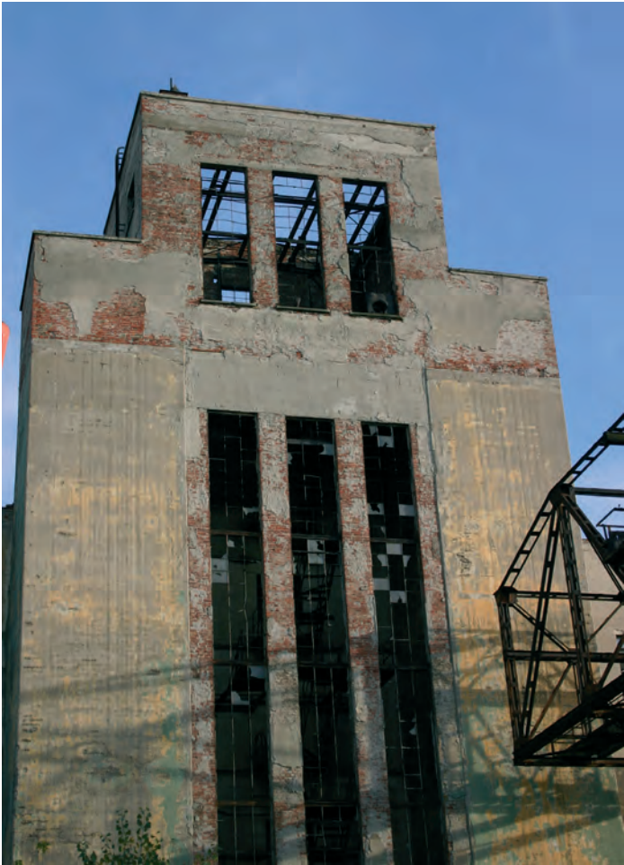
Сл. 5. Источна чеона фасада
