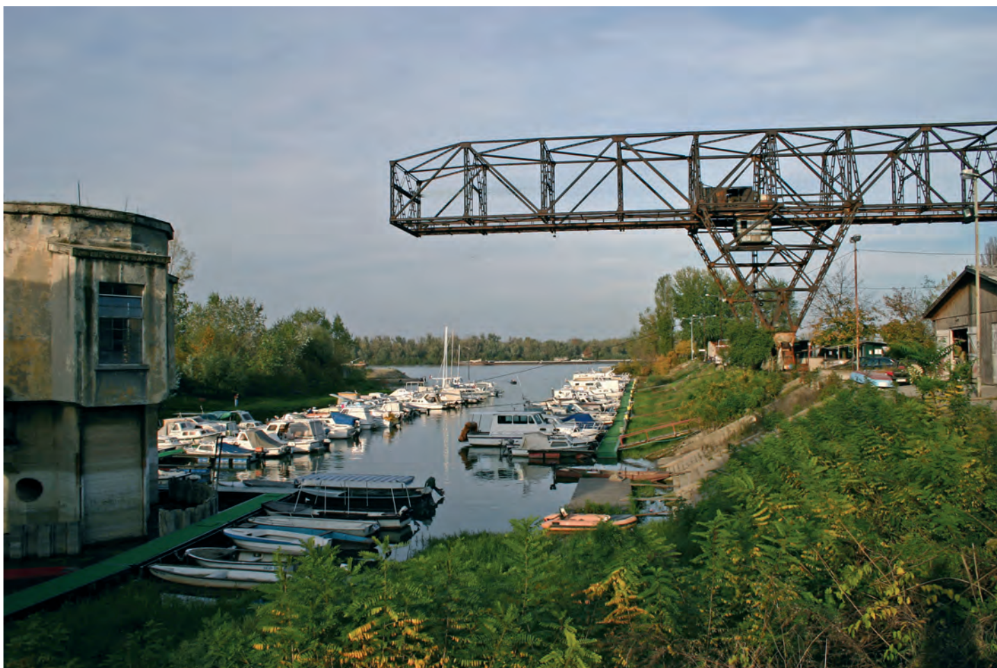
Сл. 4. Марина „Дорћол“ са краном и пумпном станицом
