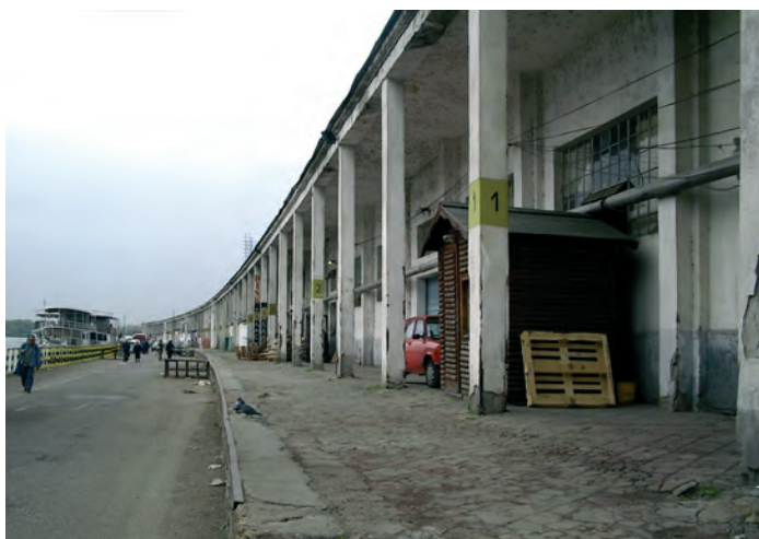
Сл. 4. Бетон хала
