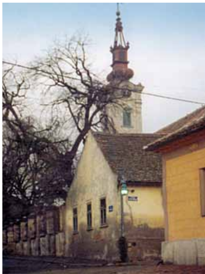
Сл. 1. Стара српска школа (1745) је бесправно рушена и подизања садашње зграде (1997)
